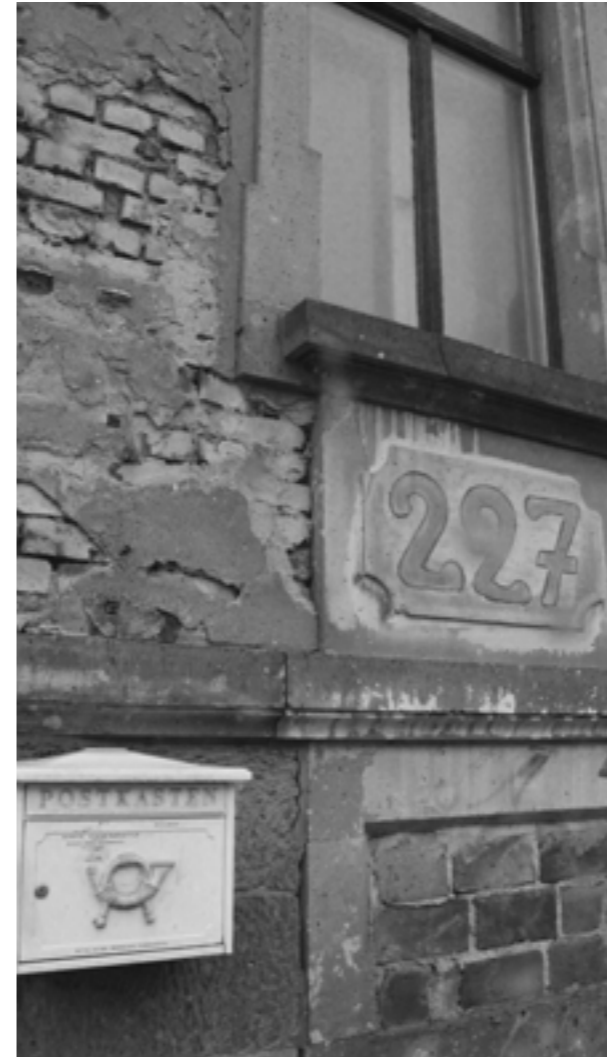
Frankenberger Straße in Chemnitz
