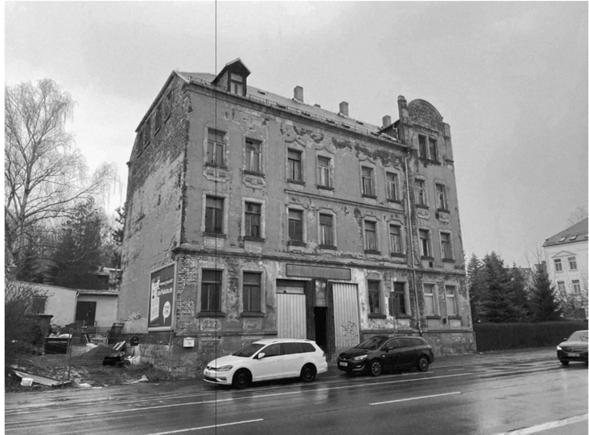
Frankenberger Straße in Chemnitz
